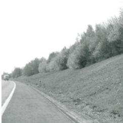
FIG. 22 > Corredores verdes e estrutura de acessibilidades. O tratamento dos taludes das vias rápidas.
