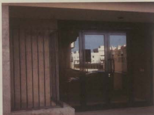
Entrada no edifício
