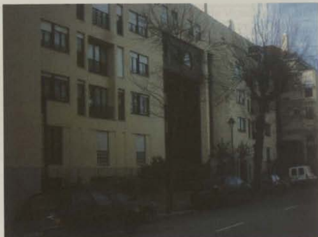
Fachada Leste (Rua Marechal Saldanha)
