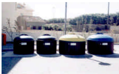
Figura 4.90 - Ecoponto molok (Rua Mares da Portela).
