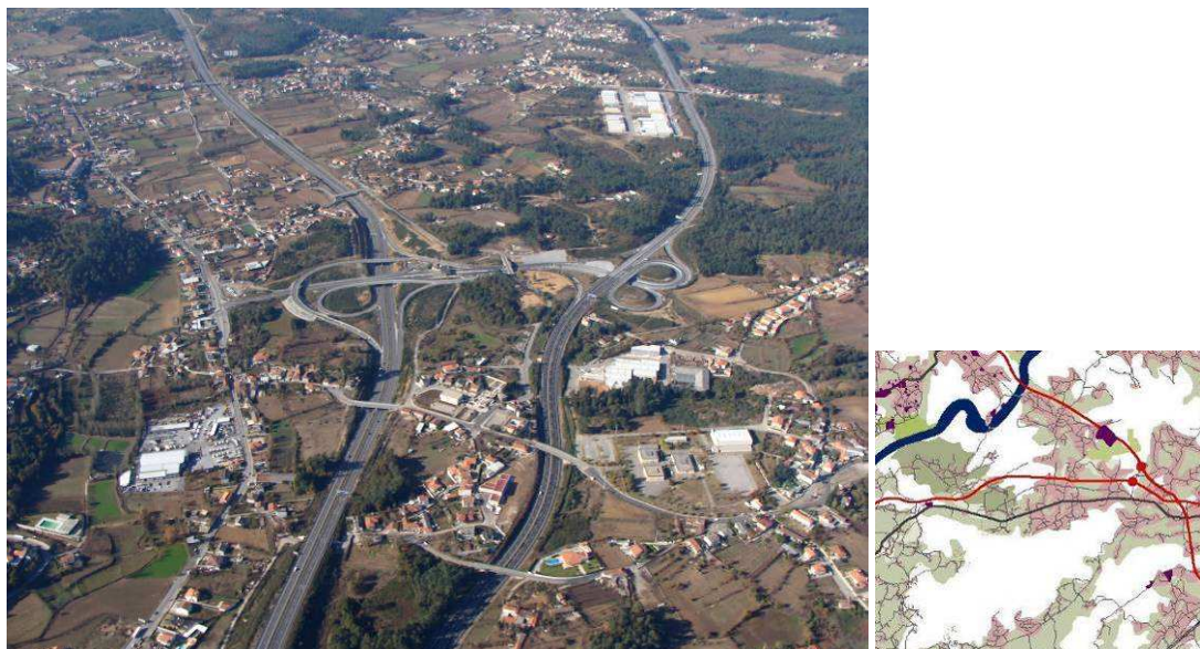
Pormenor da urbanização junto do nó da A3-A11
