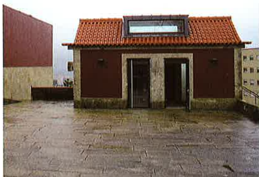
A casa da Eira antes e depois da intervenção
