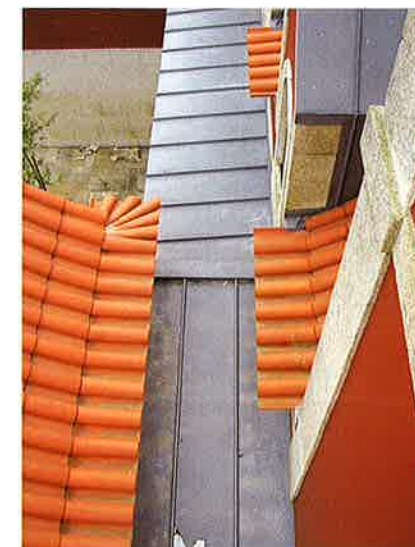
Coberturas do primeiro piso
