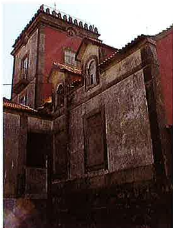
O bloco da biblioteca antes da intervenção
