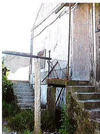
Parte do edifício original que foi demolida
