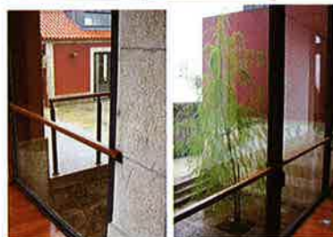
Passadiço metálico de ligação entre o edifício existente e o novo bloco
