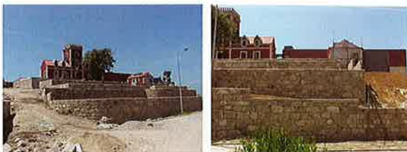
A construção dos muros de suporte
