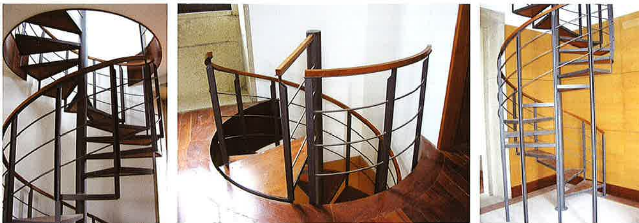
Nova escada entre pisos
