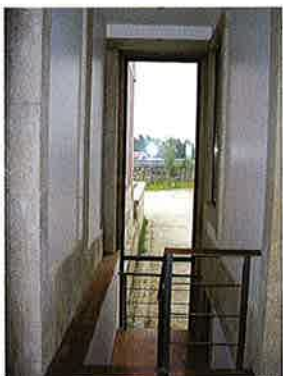
Acesso ao piso inferior
